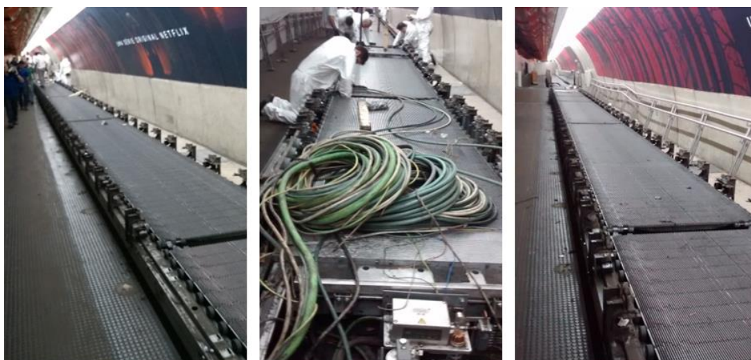
Figura 32 – Desmontagem da Balastrada
