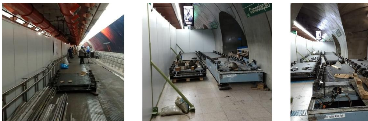
Figura 33 – Separação dos módulos e remoção destes para a plataforma de Consolação
