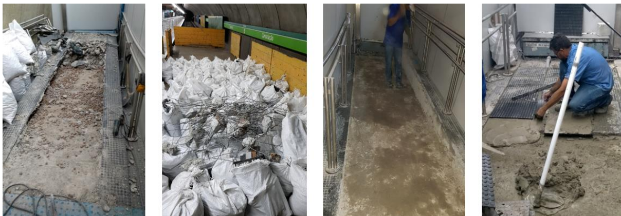
Figura 25 – Demolição da rampa de concreto e recolocação do piso plurigoma
