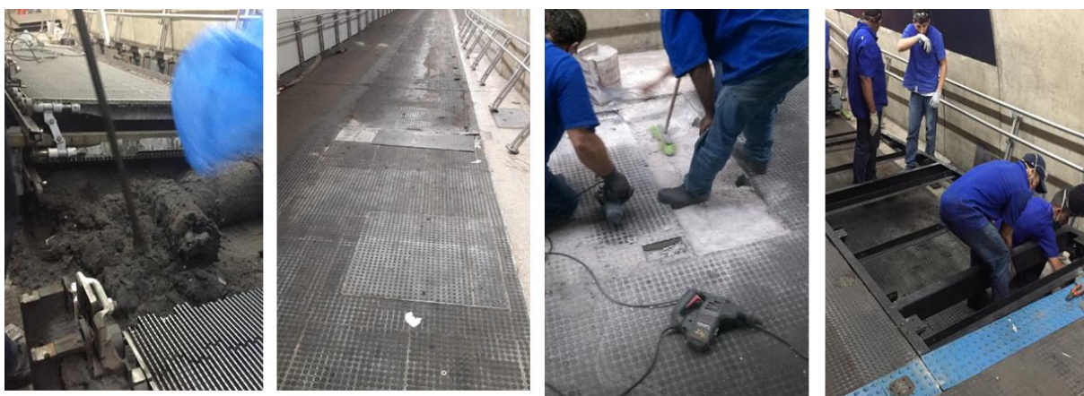
Figura 36 – Limpeza, reparo nos pisos plurigoma e colocação da rampa metálica definitiva
