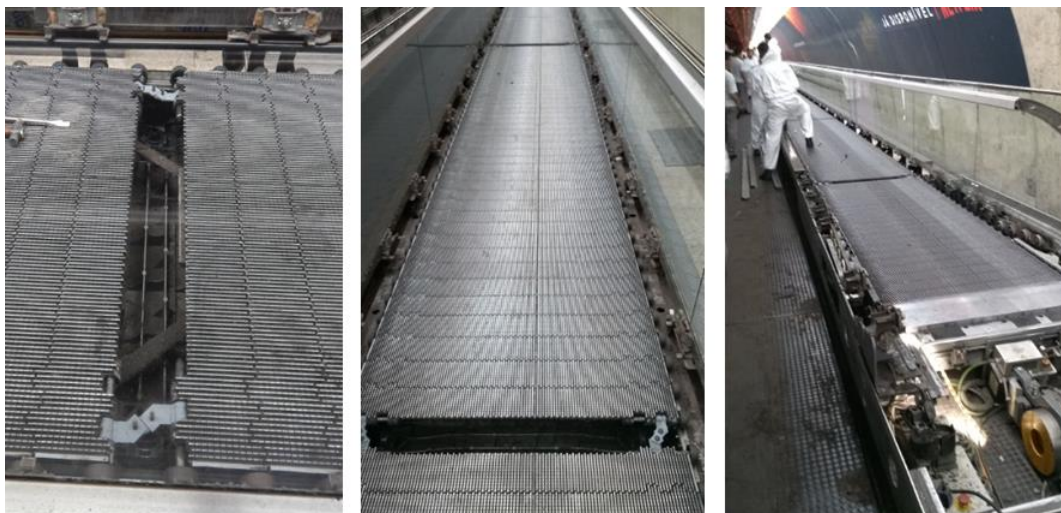
Figura 31 – Desmontagem dos paletes entre módulos da esteira
