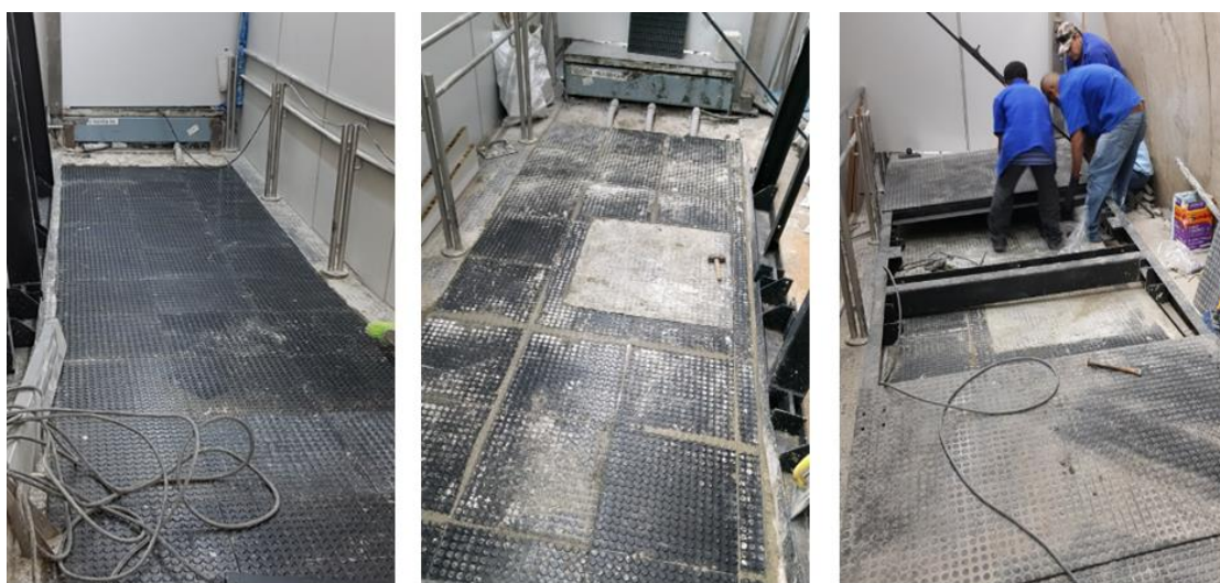
Figura 26 – Colocação da rampa metálica provisória
