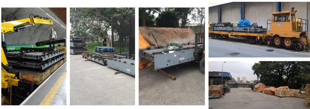
Figura 35 – Empilhamento dos módulos na gondola e descarregamento no Pátio Jabaquara
