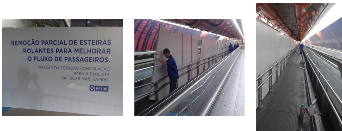
Figura 30 – Colocação de tapumes e banners para interrupção parcial do túnel
