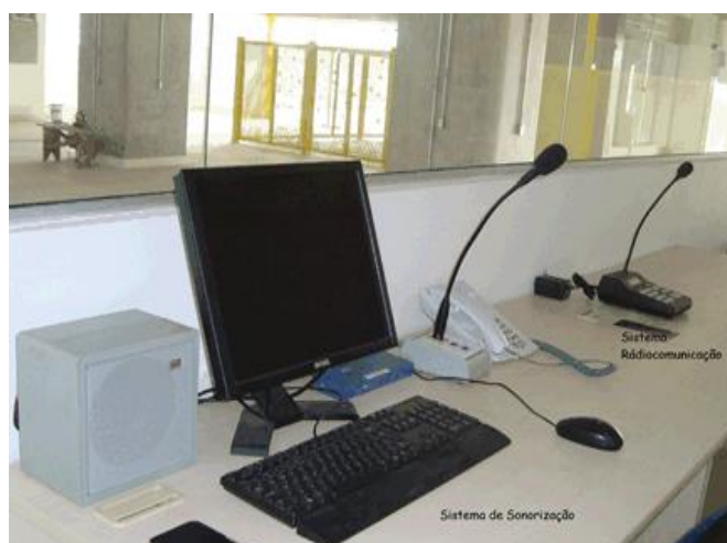
Fig.5– Console de microfone e interface instalada nas estações da Expansão Norte.
