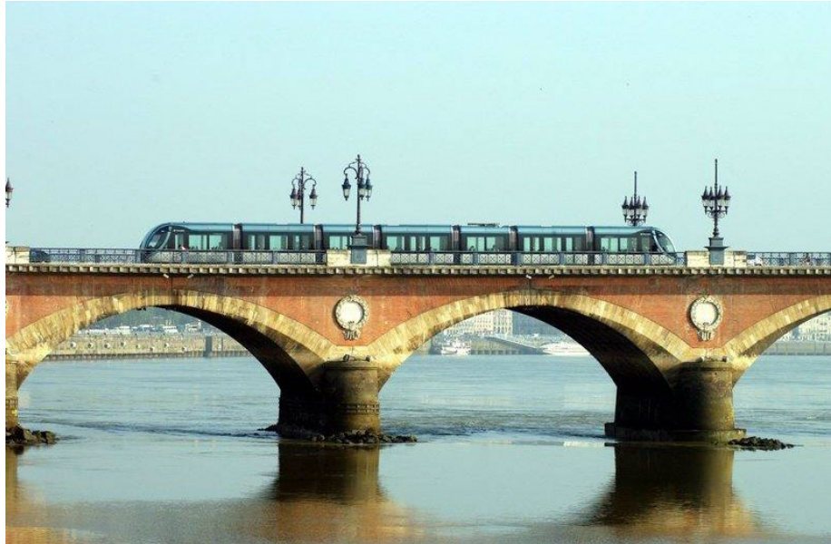
Bordeaux - 14 km de sistema sem catenária - Em operação desde 2003
