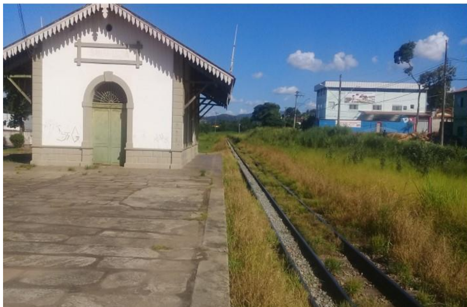
Estação de Santa Luzia - MG
