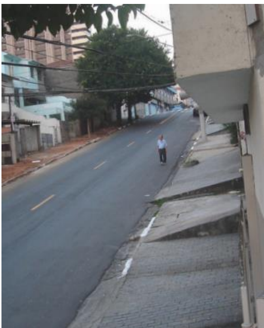
Figura 2: Pedestre andando na rua. De um lado, calçadas com rampas inadequadas, priorizando o acesso veicular ao lote. Do outro lado, calçada em reforma.
