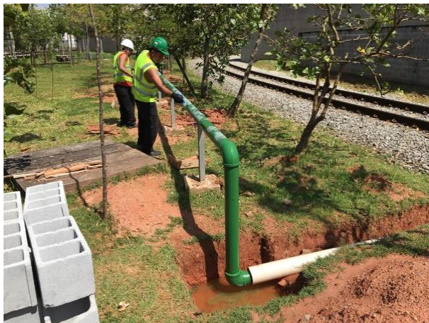
Instalação da tubulação na via no Pátio
