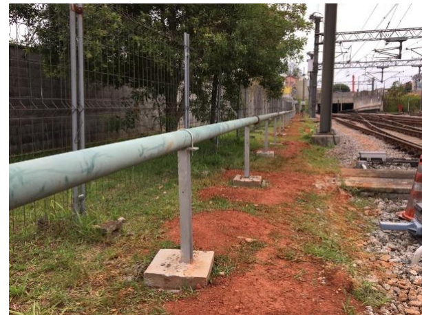
Instalação da tubulação na via no Pátio
