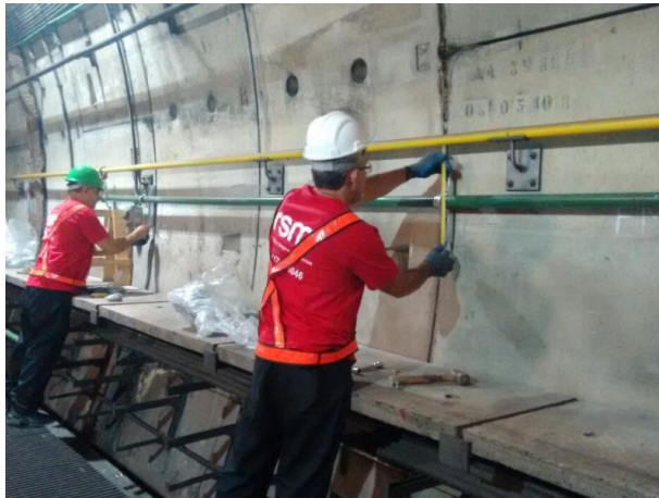
Instalação da tubulação no túnel
