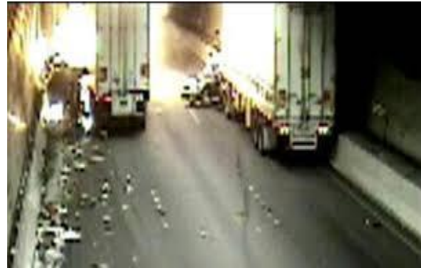
Burnley Tunnel, Austrália, 2007, 3,4 km, 3 mortes
