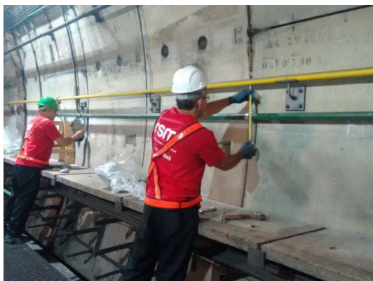
Figura 12 – Instalação da tubulação no túnel
