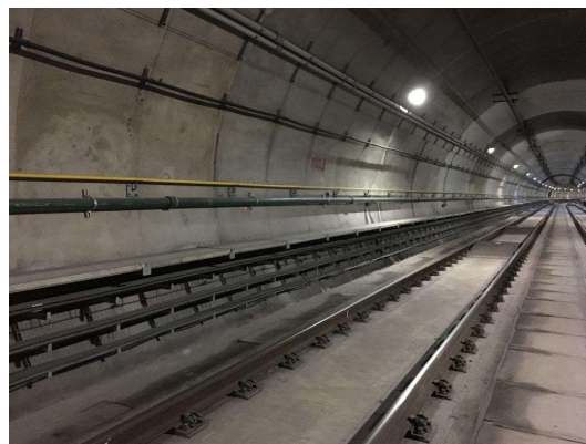
Figura 12 – Instalação da tubulação no túnel
