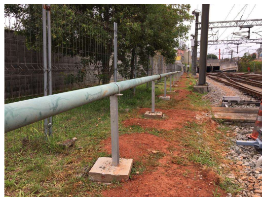
Figura 13 – Instalação da tubulação na via no Pátio
