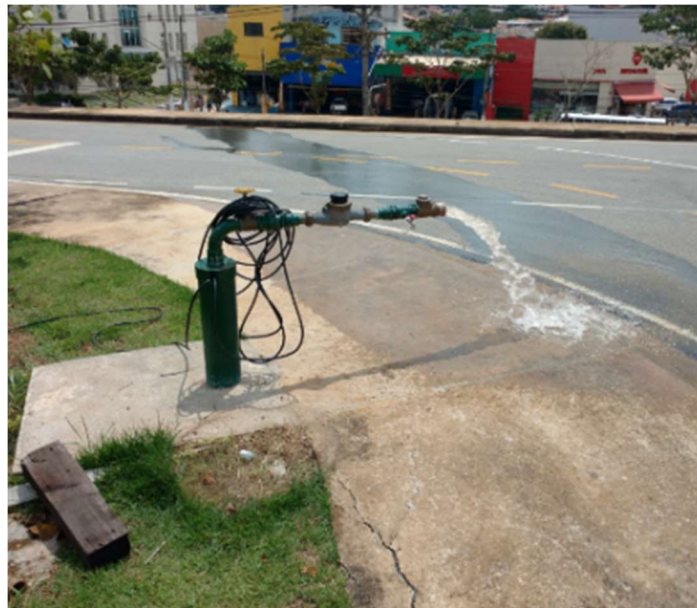
Figura 1 – Poço artesiano instalado no Pátio de Manutenção e Estacionamento Vila Sônia
