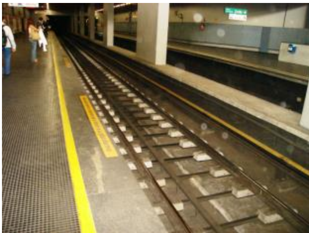
Figura 1- Linha em túnel sobre dormentes de concreto e radier
