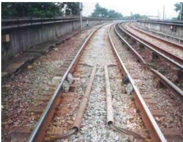
Figura 2 - Linha férrea a céu aberto, com lastro de pedras britadas.
