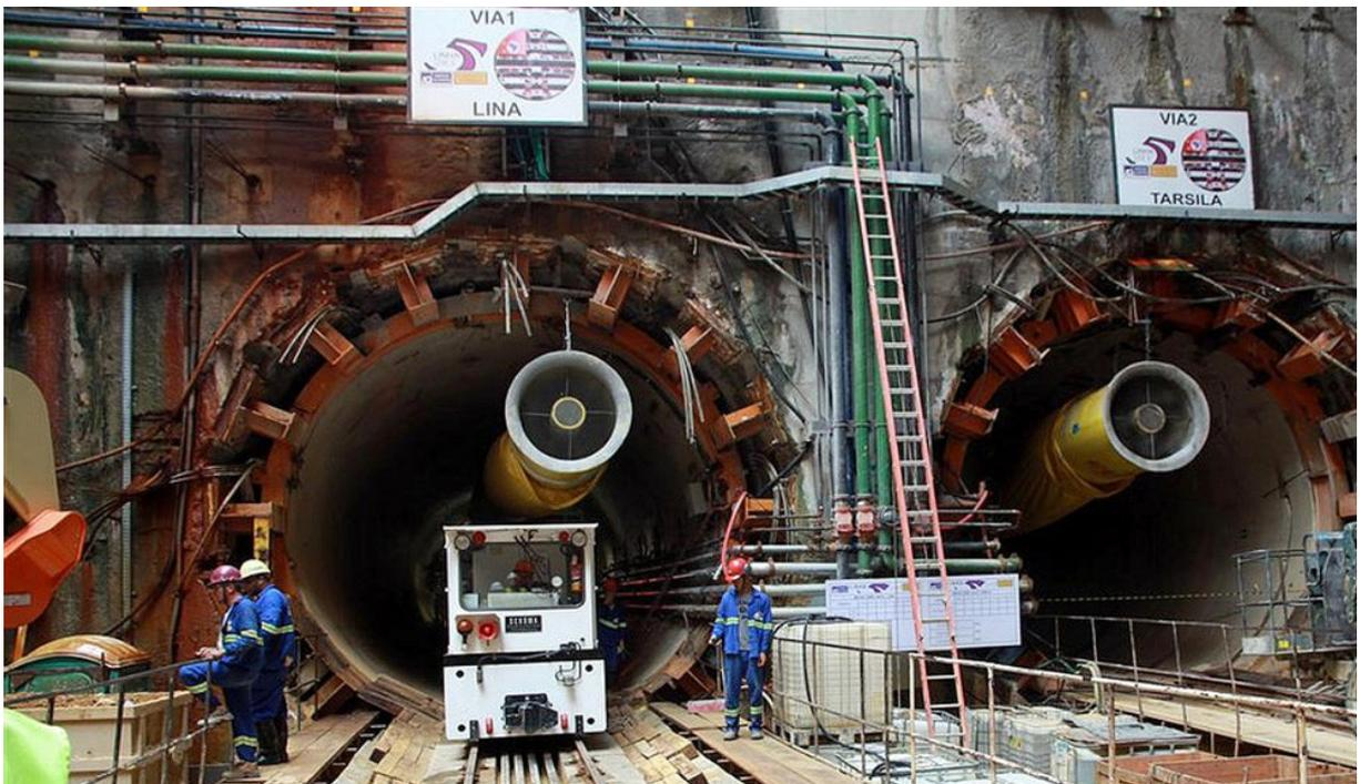
Fig. 1 - Dupla de tuneladoras *Tatuzetes* "Lina" e "Tarsila" de  $\varnothing$  6,9 m na Linha 5 Lilás do MSP
