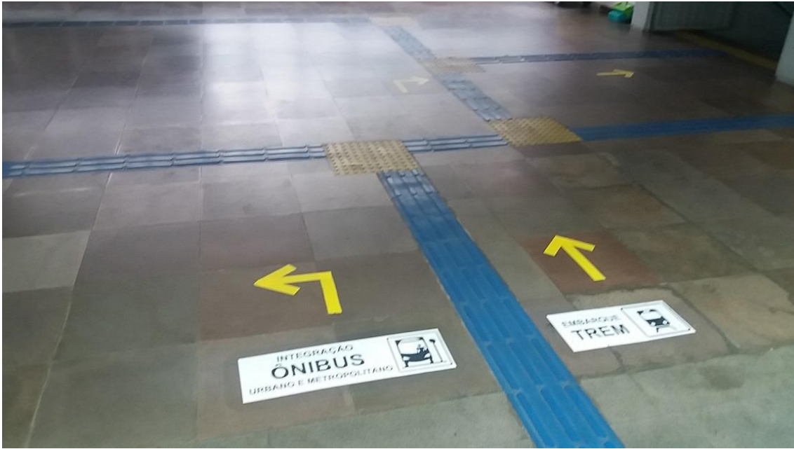
Figura 35 - Detalhe da Sinalização de Piso
