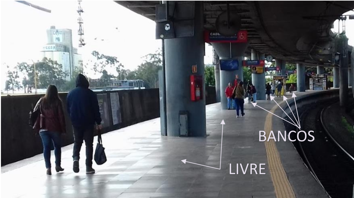
Figura 20 - Vista da Plataforma após intervenção
