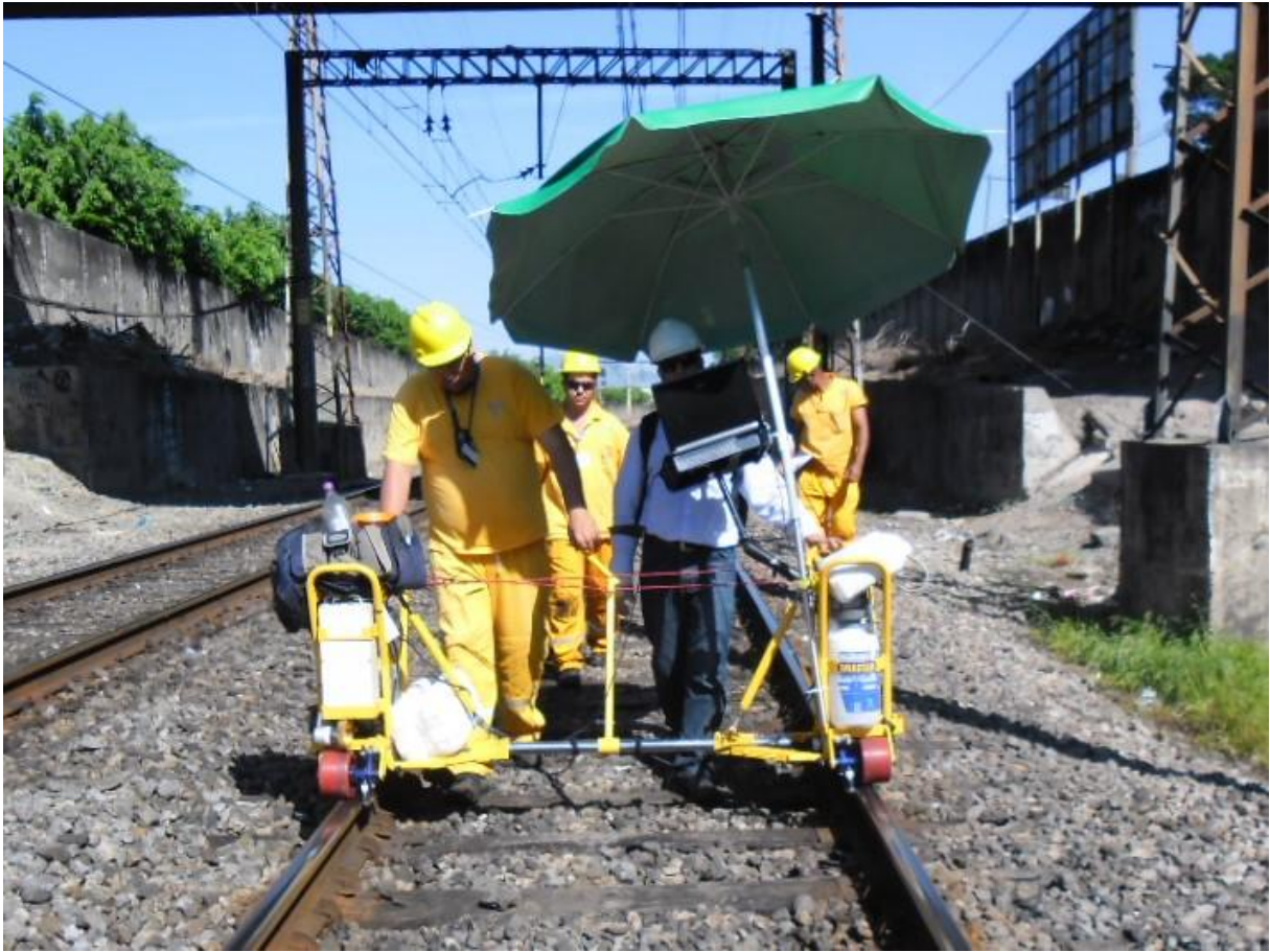
Figura 2 – Equipamento de ultrassom utilizado para detecção de defeitos internos nos trilhos
