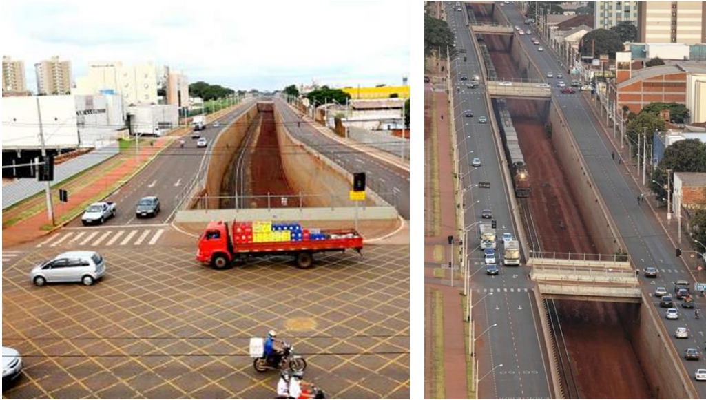
Figura 7 – Solução de trincheira na cidade de Maringá/PR, operada pela Rumo Logística.
