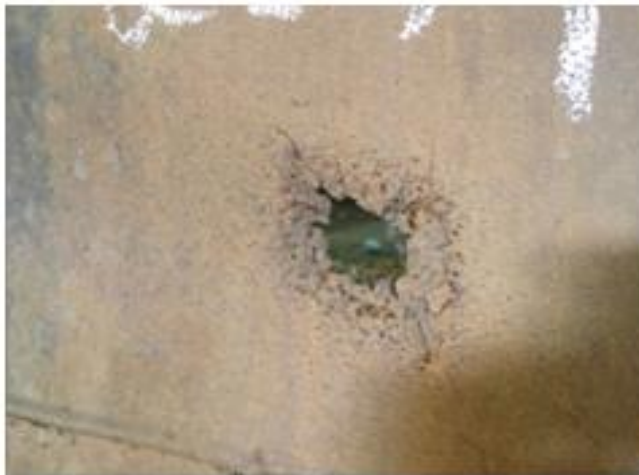
Figura 3: Chapa de vagão corroída
